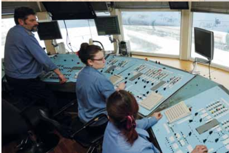
Диспетчерская сортировочной горки – это почетное место работы на станции. Дежурный и два оператора контролируют спуск вагонов с горки.
